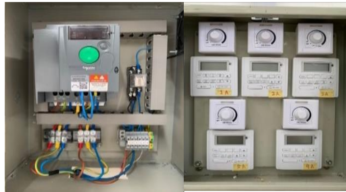
Gambar 7. Realisasi komponen dalam boks kontrol VSD
