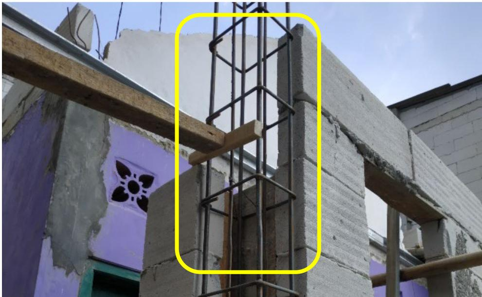
Gambar 3. 39 Tidak memasang besi angkur pada dinding dan kolom sehingga tidak ada ikatan yang kaku antar komponen bangunan;
