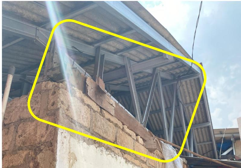
Gambar 3. 40 Ampig pada atap tidak dipasang struktur beton bertulang untuk perkuatan komponen atapnya
