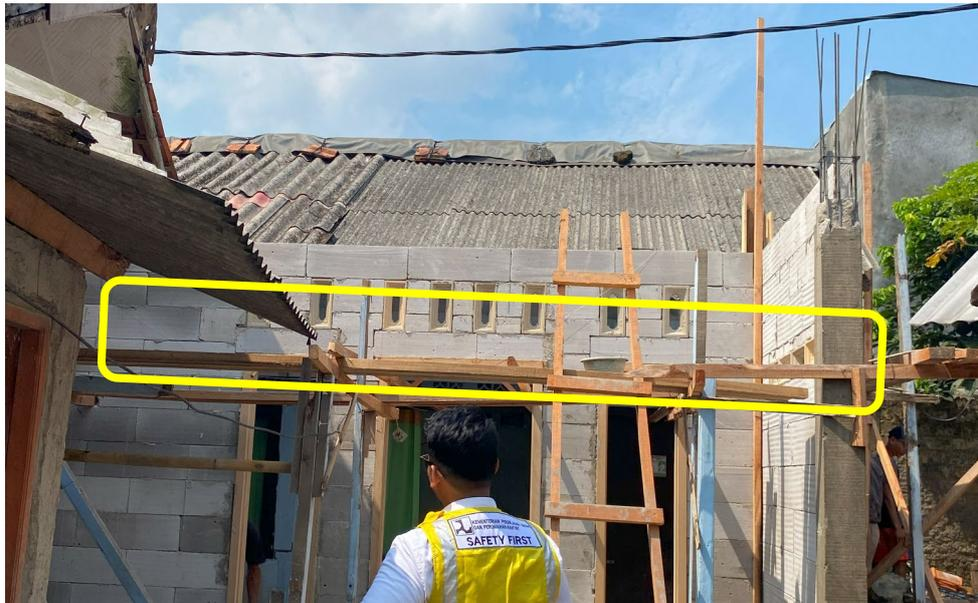
Gambar 3. 38 Tidak terdapat balok pinggang di atas kusen untuk perkuatan struktur bangunan
