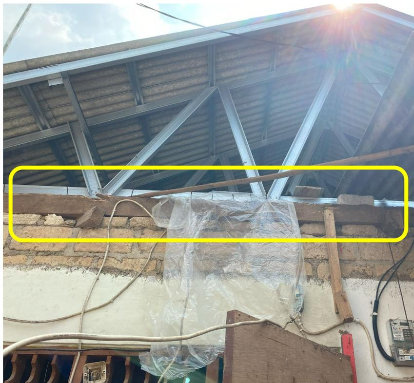
Gambar 3. 47 Tidak terdapatnya balok utama pada struktur utama
