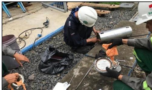
**Gambar 6. Penggantian Filter Kompresor Kwangshin C-100**
