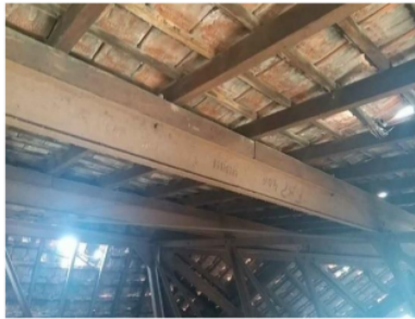
g. Roof beam
