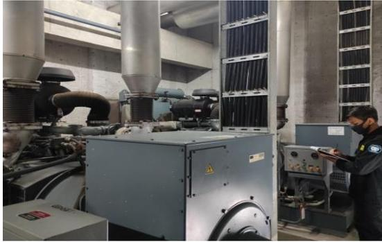
Gambar II.1 Generator Set Stamford dengan daya 670 kVA.
