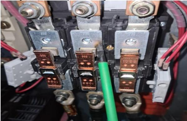
Untuk masalah pada *soft starter* tersendiri menurut hasil observasi yang dilakukan penulis adalah sangat jarang terjadi kerusakan pada *soft starter* itu sendiri kecuali adanya kondensasi yang terjadi pada sistem pendingin panel yang mengakibatkan tetesan air atau embun sehingga mengenai *circuit board* pada *soft starter*
