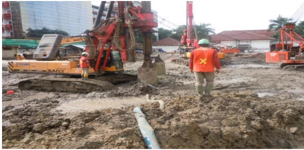
Gambar 2. 23 pengeboran membuat bore pile
