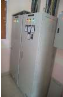
Gambar 2 Tampak depan Panel UPS
