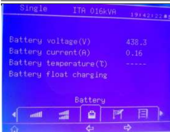
Gambar 15. Display Battery UPS Dalam Kondisi Full Charging
