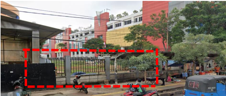
Gambar 4.14 Kondisi Pagar Pembatas Blok di Pasar Senen Jaya Blok III Sumber: Dokumentasi Hasil Olah Survei Penulis 2021
