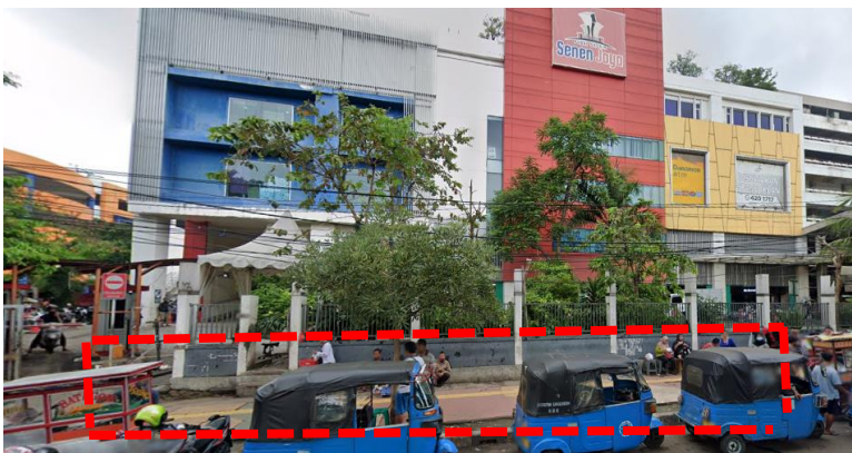
Gambar 4.15 Kondisi Pagar Pembatas Blok di Pasar Senen Jaya Blok IV & V Sumber: Dokumentasi Hasil Olah Survei Penulis 2021
