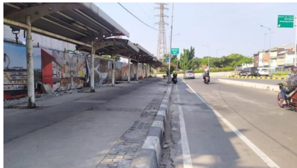
Gambar 4.13 Kondisi Jalur Pedestrian yang belum sesuai dengan Kriteria TOD di Jl. Pasar Senen (depan Pasar Senen Jaya blok 1,2,3,4,5) Sumber: Dokumentasi Hasil Olah Survei Penulis 2021
