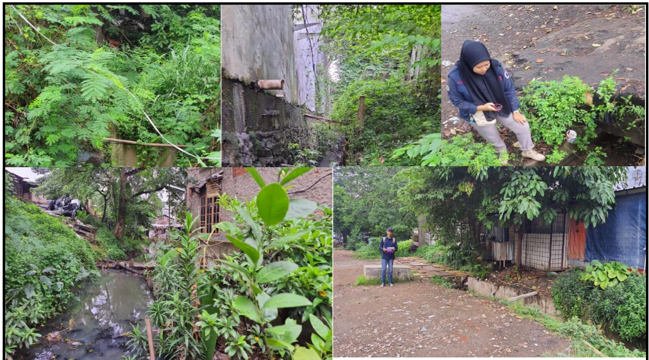
Gambar 5.8. Tampak Saluran drainase eksisting yang seharusnya menyambung ke depan BKT
