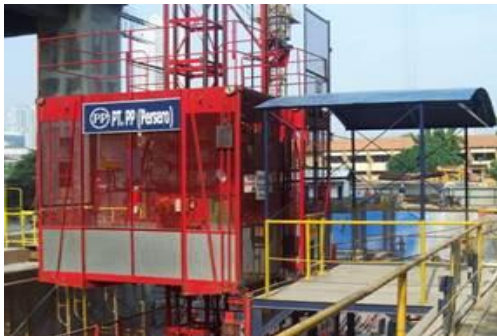
Railing di sekeliling plat lantai
