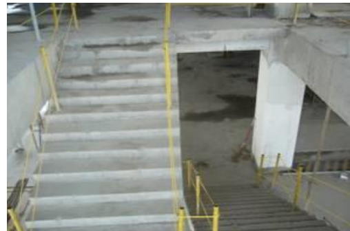
Railing sepanjang tangga
